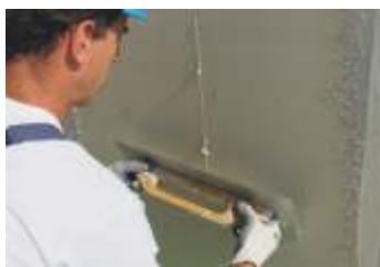
Applicazione della prima mano di REABILITA CAL
