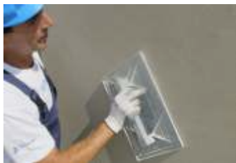
Spatolatura a taloscia della seconda mano
