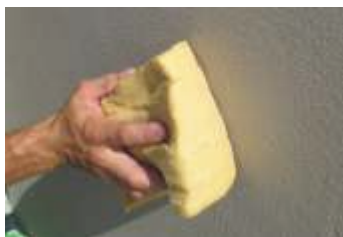
Spugnatura della superficie per un intonaco fine
